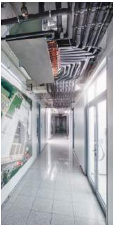
Винаги леснодостъпни: контролерите Hybrid BC са разположени в окачения таван на коридора.
