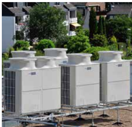
Интегрираната функция на топлинна рекуперация на VRF R2 технологията позволява енергоспестяване до 40 %.
