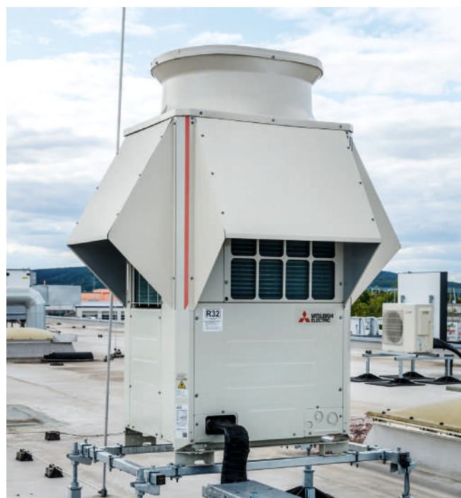
В допълнение към по-ниския ПГЗ, R32 също има и около 20% по-висока обемна охлаждаща мощност в сравнение с R410A и около 4,4% по-висока теоретична COP.
