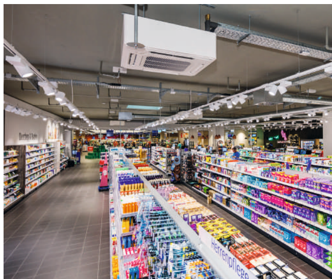
Общо четиринадесетте 4-пътни таванни касети осигуряват циркуляция на въздуха без течение в търговската зона.
