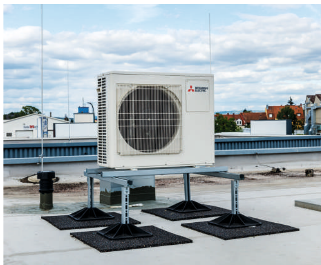
Външното тяло от серията М има охлаждаща мощност от 7,2 kW и захранва три вътрешни тела в помещенията за персонала.
